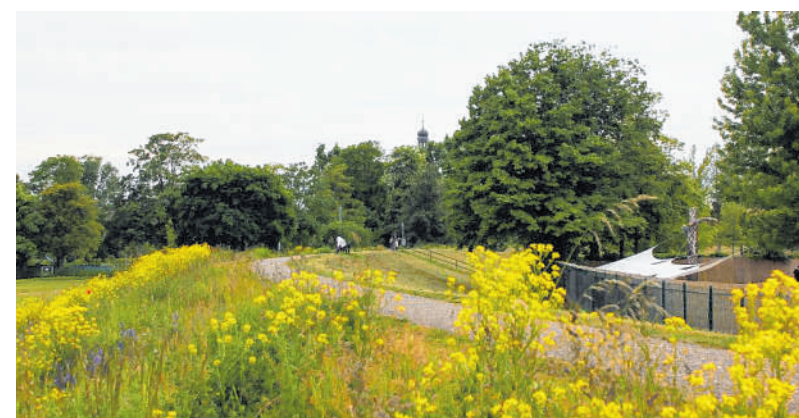
Der Hochwasserdamm in Ilvesheim.
