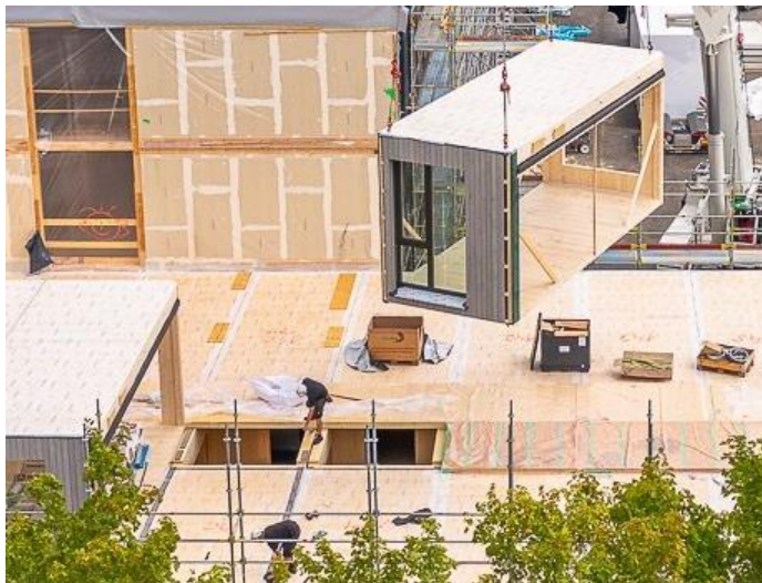
Modulbauanlieferung in Prüm, 2022 ©digitalgrafie/Blitzwerk
