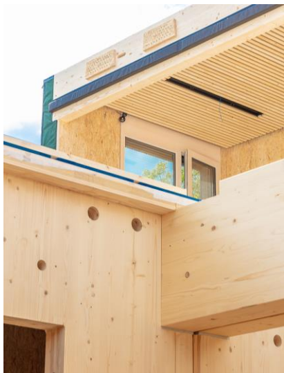
Bilder Bauausführung ©Blitzwerk
