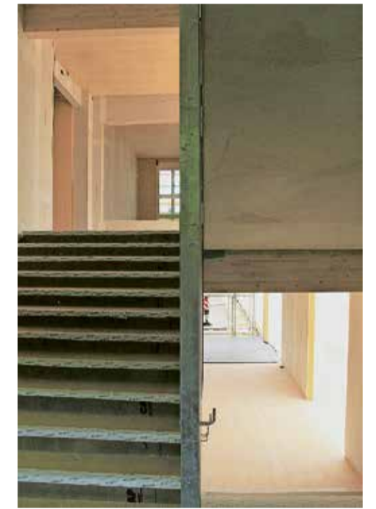
Die neue Offenheit: Aufgang vom Erdgeschoss in die erste Etage der Modulschule in Prüm.
